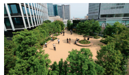
大阪梅田ツインタワーズ・サウス屋上広場
